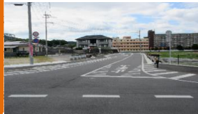
※道路の改良 ④
