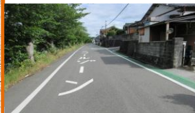
※路面標示・カラー塗装実施 ①
