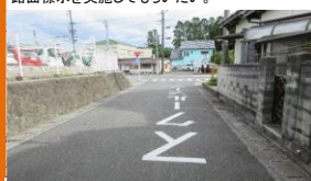
※路面標示実施 ⑧
