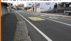
※路面標示を設置 ⑨
