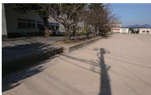
運動場段差部分
