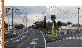
※路面標示・看板設置 ⑱
