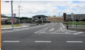
※道路の改良 ④
