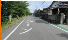
※路面標示・カラー塗装実施 ①
