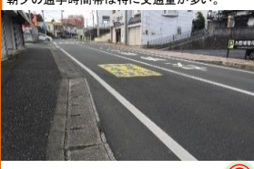
※路面標示を設置 ⑨
