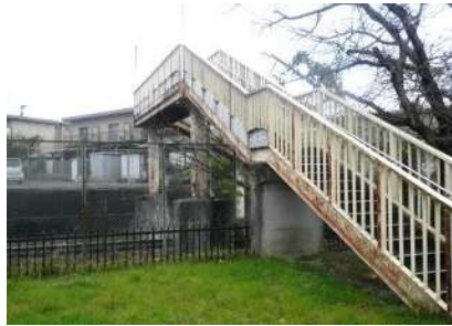
堀川団地横断歩道橋 橋長 25.5m (2018年施工)
