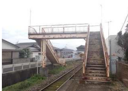
糸田駅二号横断歩道橋 橋長 29.9m (2019年施工)
