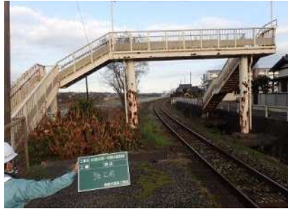
糸田駅一号横断歩道橋 橋長 26.6m (2017年施工)
