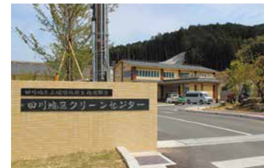
▲ 田川地区クリーンセンター
