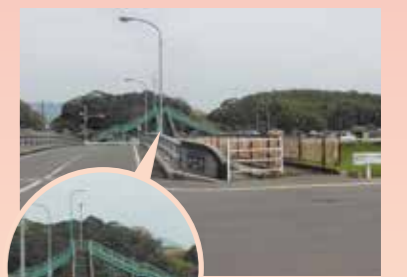
▲ 撤去予定の 大熊橋歩道橋
