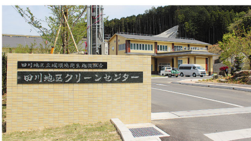
▲ 田川地区クリーンセンター
