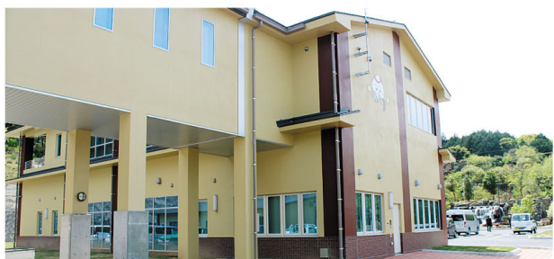
▲田川地区クリーンセンター
