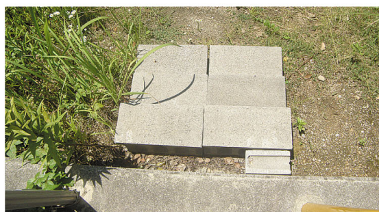
▲道の駅いとだ裏手の避難通路
