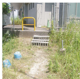
▲道の駅いとだ裏手の避難通路
