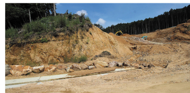
▲施設建設地造成中
