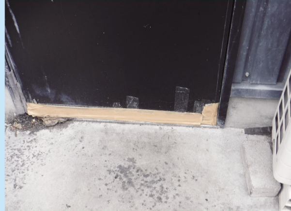
◀フードコートの従業員用ドア交換
