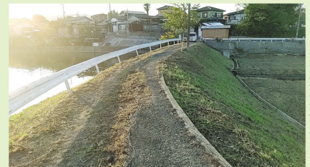
▶大堤池堤体道路
