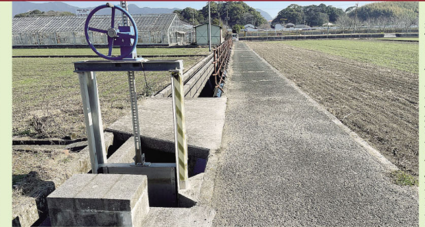
▶稗田・七十石線水路床板打設
