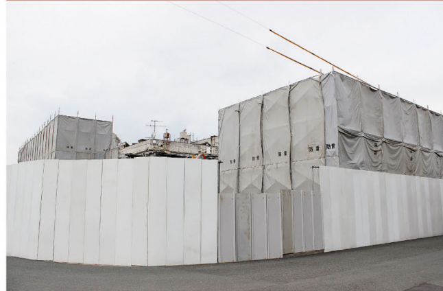
▲防音シートに囲まれる文化会館
