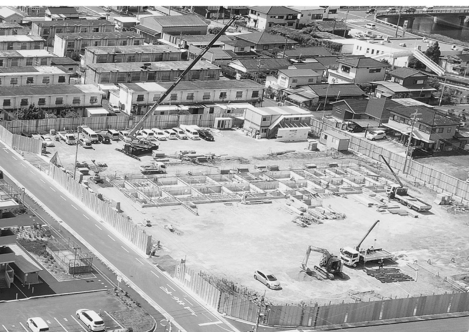
▲D棟建設現場
