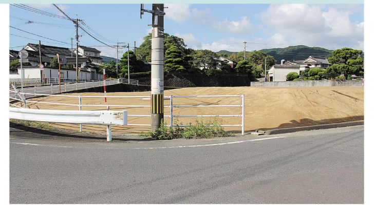
▲ 南糸田地区・交差点改良工事 (県道赤池糸田線)
