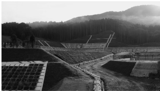
▲大任町に建設中のし尿処理施設(汚泥再生処理センター)
