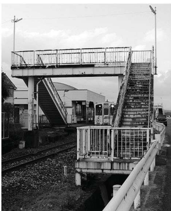
糸田駅2号横断歩道橋
