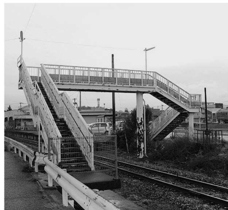
糸田駅1号横断歩道橋
