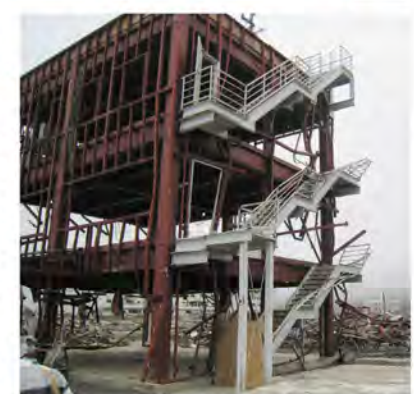
骨組みだけとなった防災対策庁舎 (宮城県南三陸町)
